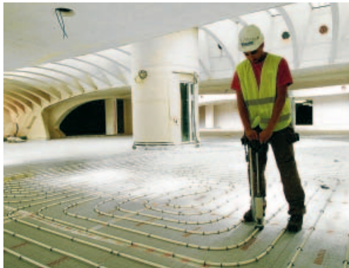
On installe actuellement les tuyaux de chauffage. ■ MICHEL CRAHAY
