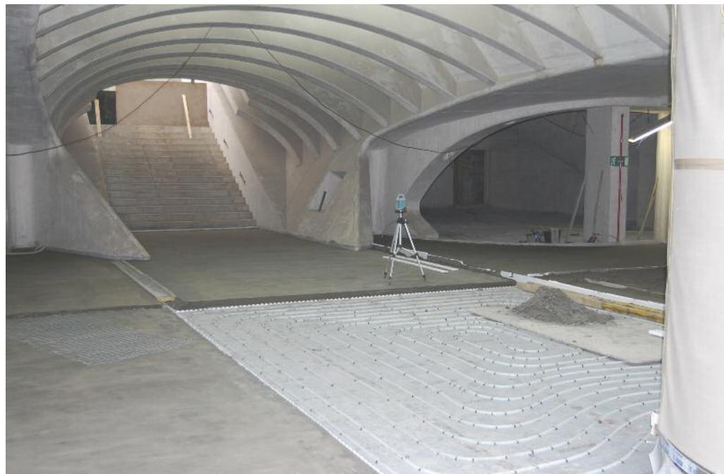
On voit bien ici la pose de la chape par dessus le treillis.
